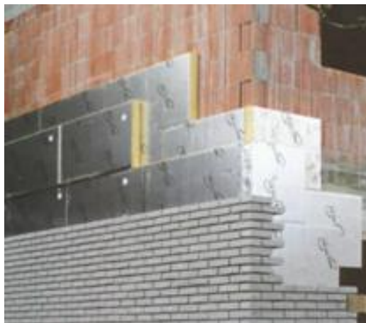
6.3-сурет – Ылғалды климат жағдайында көп қабатты тас қабырғаларды тұрғызған кезде фолгадан дайындалған қорғаныс қабаты бар минерал-мақталы плиталарды қолдану
